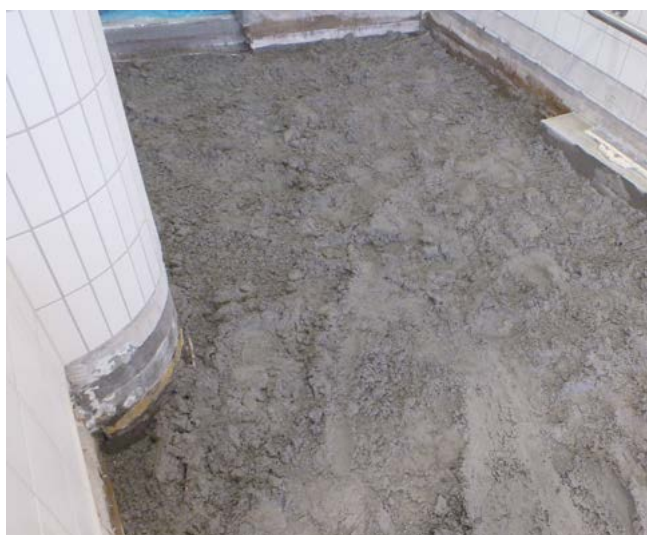
Einbau eines Verbundsestriches im Großküchenbereich
