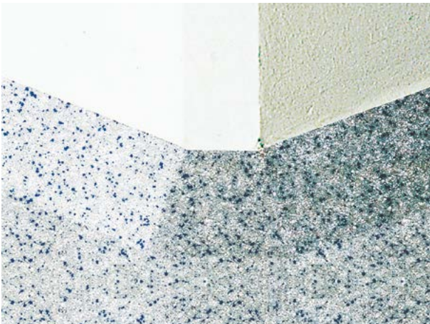
Dreikantsockel werden exakt von Hand modelliert. DKFZ, Heidelberg
