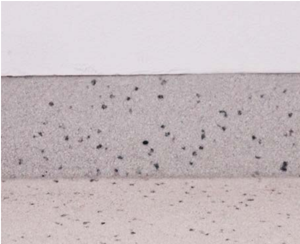
Senkrechtsockel auf schwimmendem Estrich
