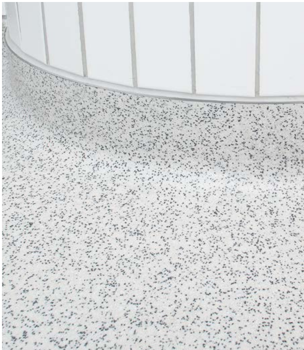
Hohlkehlen im Verbund werden in einer glatten Oberfläche an Säulen modelliert.
